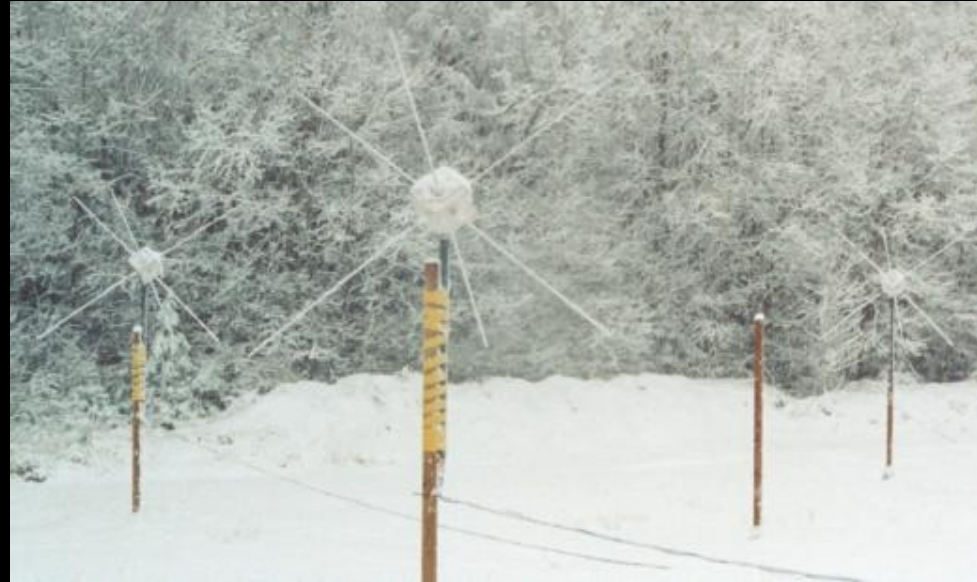
LOIS tripole array in Växjö, Sweden
